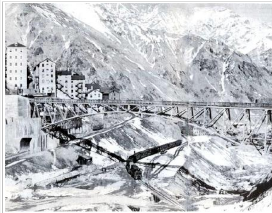
Fig.1. Vista del puente Rebolledo, la solana del cerro Negro, y la quebrada de Coya. Se observa el ferrocarril Rancagua- Sewell, y el edificio N°152 al centro del conjunto construido. Circa 1978. Fte.: Revista Chilena de Ingeniería, Anales del Instituto de Ingenieros N°374, julio - septiembre 1978, p. 43.
