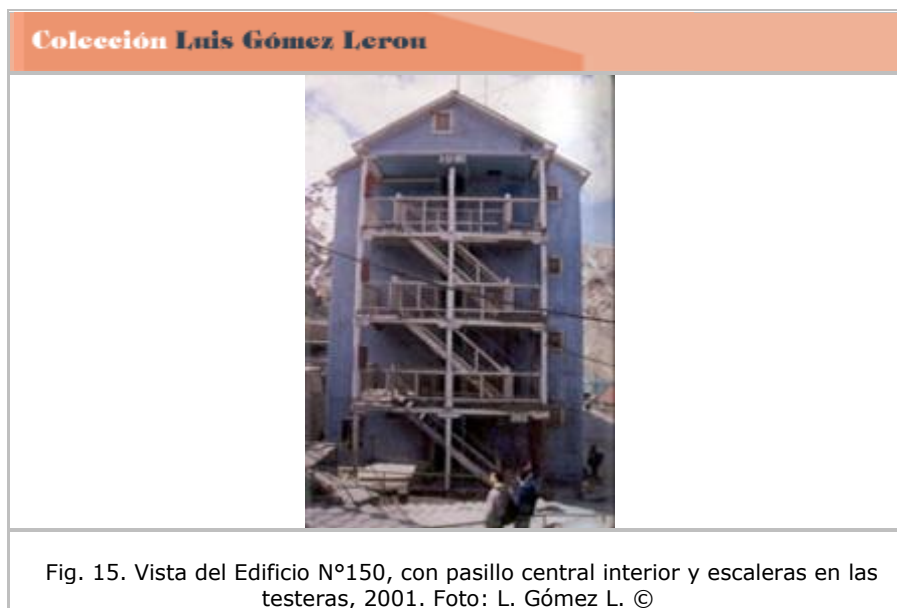
Figura 15.-Vista del Edificio N°150.
