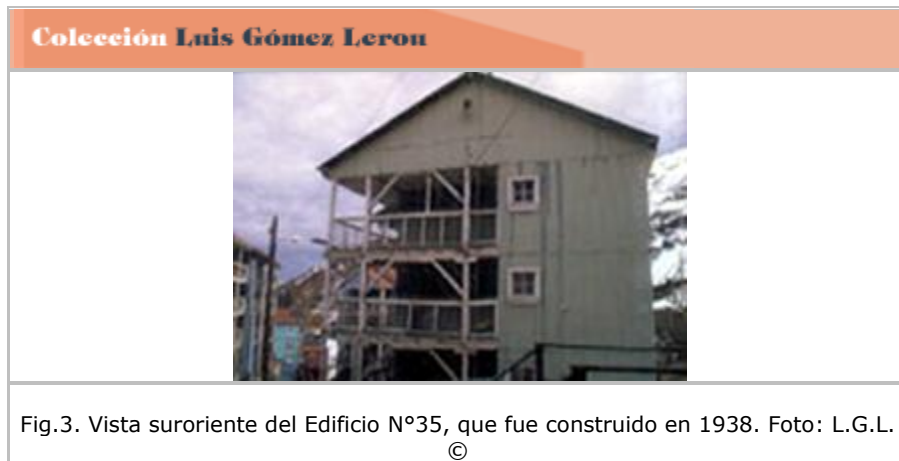
Figura 3.- Vista suroriente del Edificio N°35.
