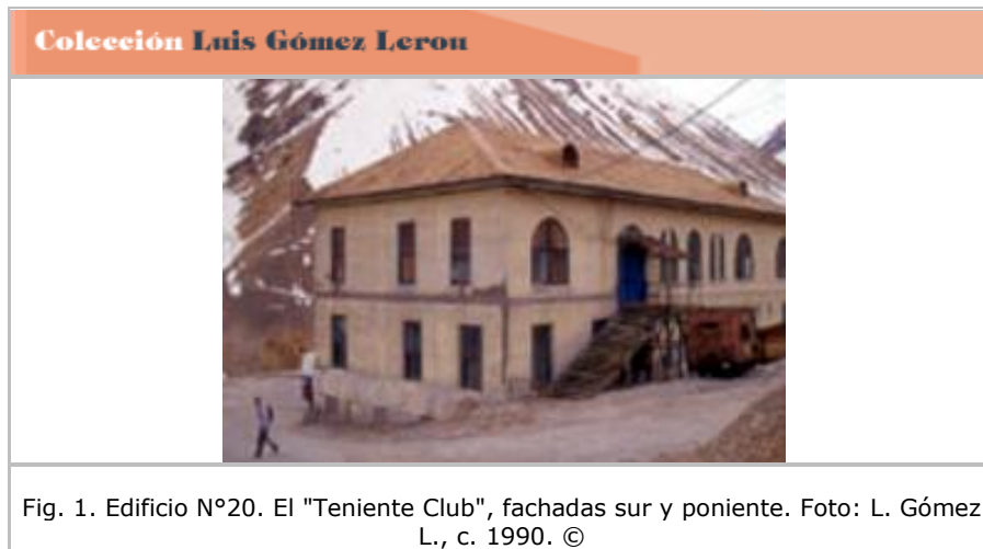
Figura 1.-Edificio N°20. El "Teniente Club".
