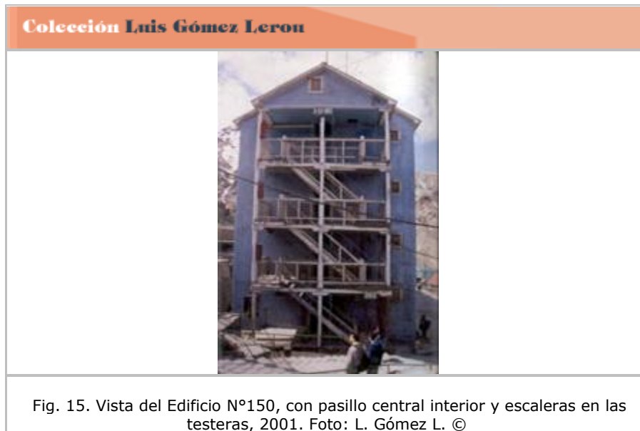
Figura 15.-Vista del Edificio N°150.
