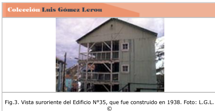
Figura 3.- Vista suroriente del Edificio N°35.
