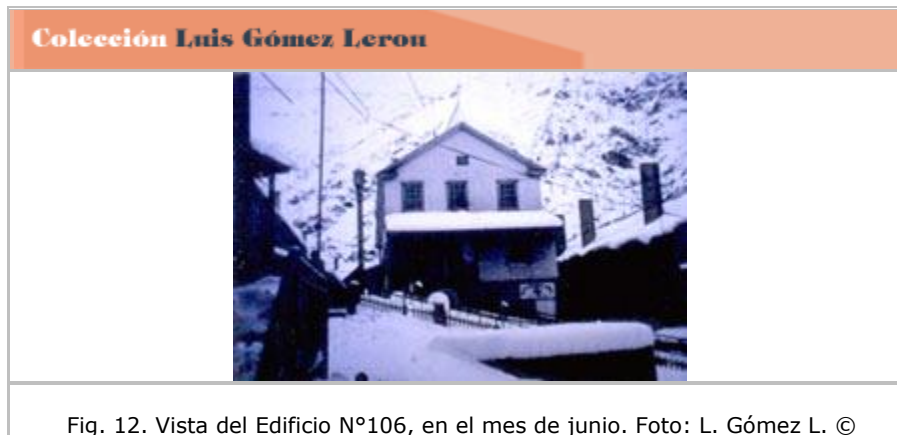
Figura 12.-Vista del Edificio N°106(a).
