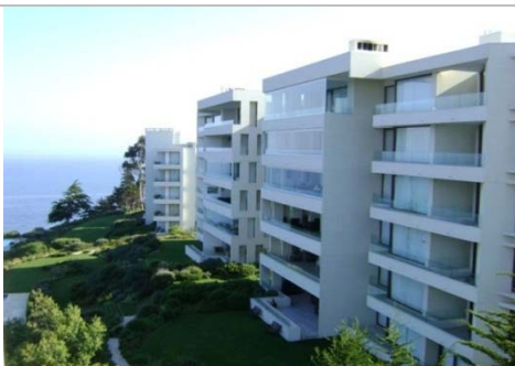
Fig. 11.- Fotografía de un edificio del condominio Marbella.
