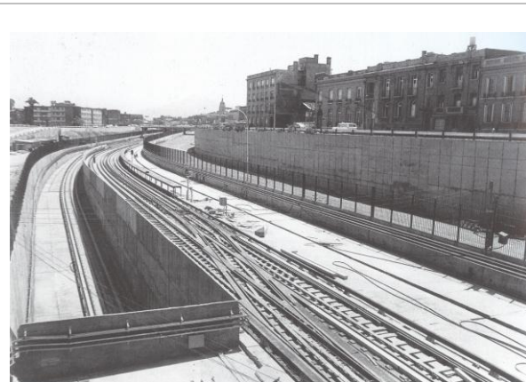
Fig.15.-Complejo Vial Avda. Norte-Sur en construcción, en proximidad a la Avda. del Libertador B. O'Higgins R., vista al norte, c. 1974. Se observa aún, al fondo, la torre de la iglesia Santa Ana. Foto: G.G.G., en Archivo M.O.P. Chile.
