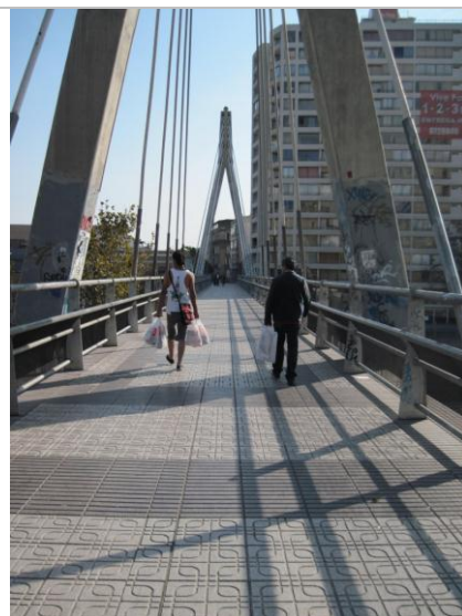
Fig.23.-Pasarela peatonal sobre la Norte-Sur, y fachadas de nuevo edificio residencial a menos de 3 m de ella.
