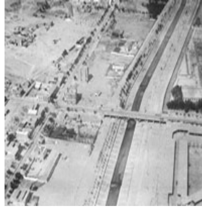
Fig. 6. Obras de canalización y saneamiento del Río Manzanares en 1914-1925, tramo comprendido entre el Puente de los Franceses y el Arroyo Abroñigal.
