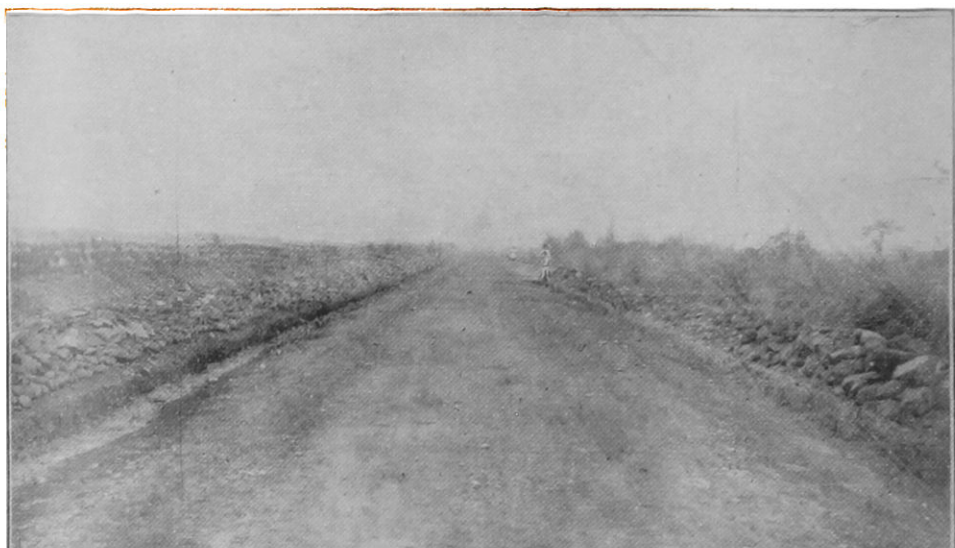
CAMINO DE SAN BERNARDO A PUENTE ALTO
