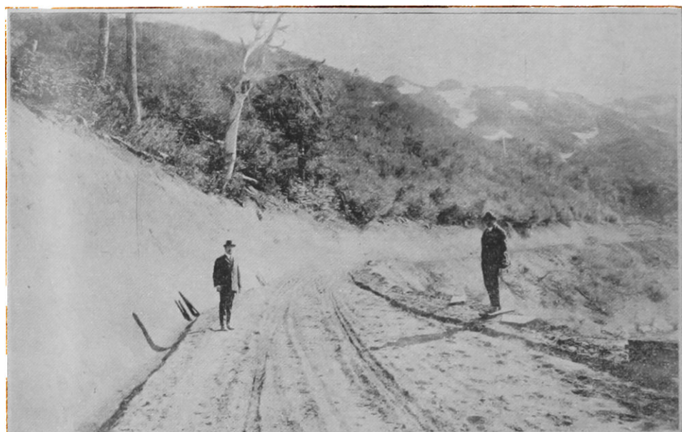
CAMINO DE LAS TRANCAS A LAS TERMAS PERIODO DE CONSTRUCCION
